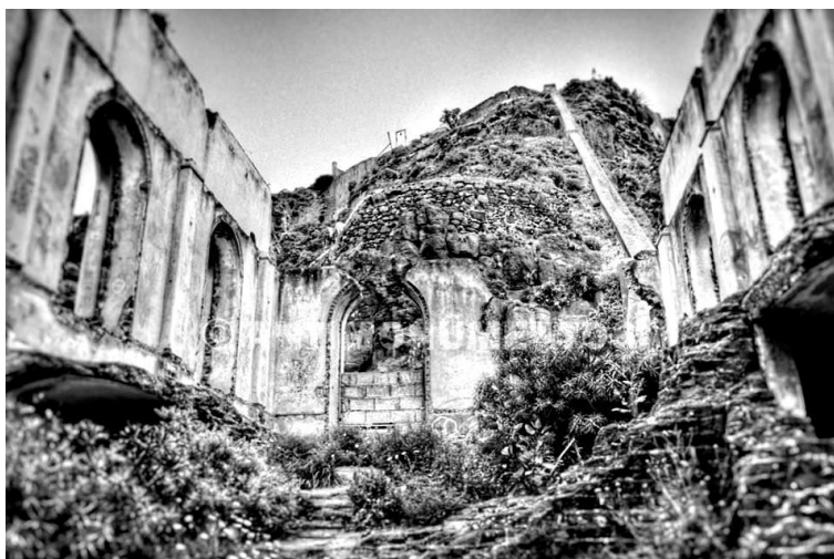
Imagen 3. Interior de la estación de bombeo de agua “La Gordejuela”, en la isla de Tenerife.
