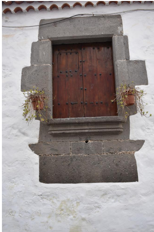
Foto 8: ventana de la vivienda ubicada en la calle Los Marqueses de Arucas, 12. Probablemente del siglo XVIII. Foto: Antonio Jiménez.
