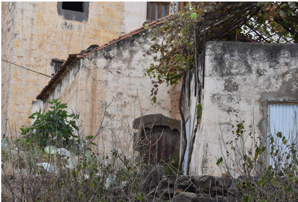
Foto 9: vivienda tradicional con presencia de arco conopial, probablemente del siglo XVIII. Foto: Antonio Jiménez.
