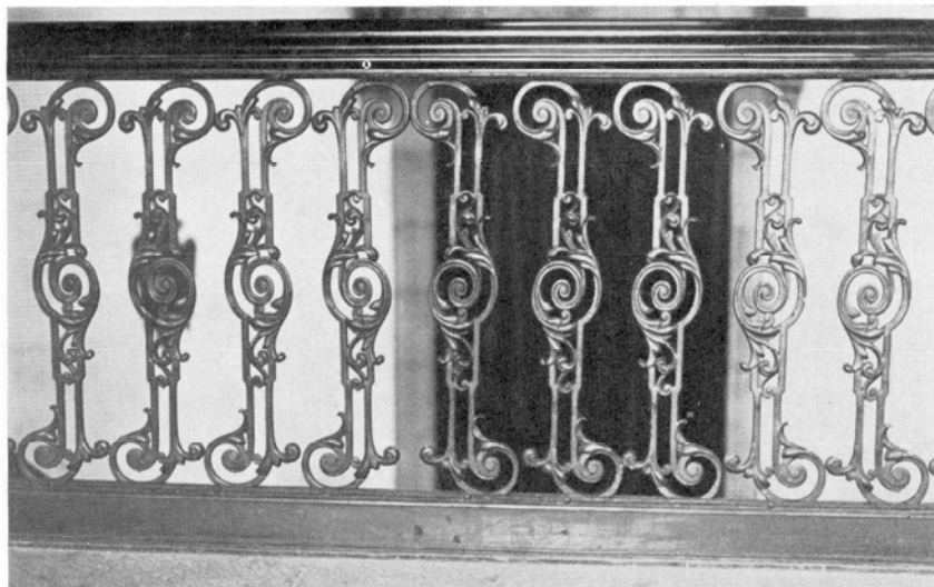
14. Balaustres de la escalera principal
