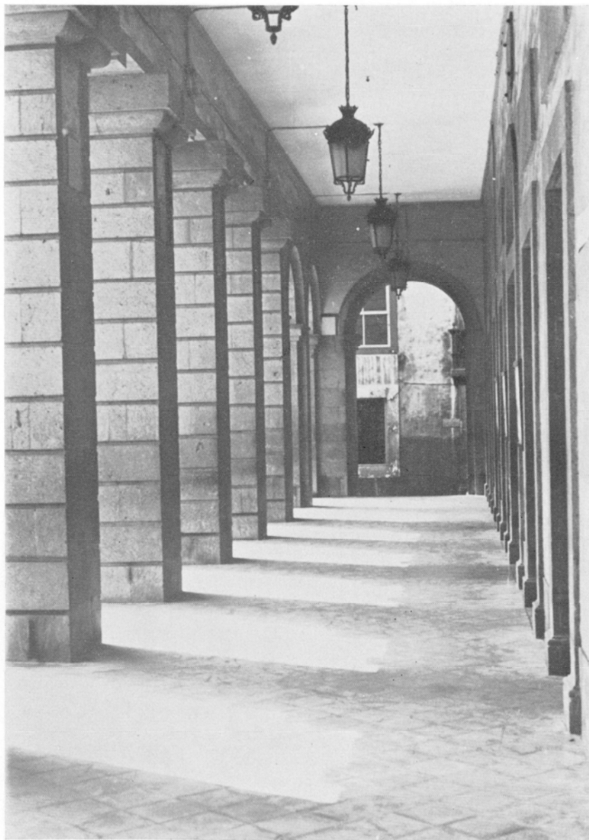
10. Pórtico de la planta baja
