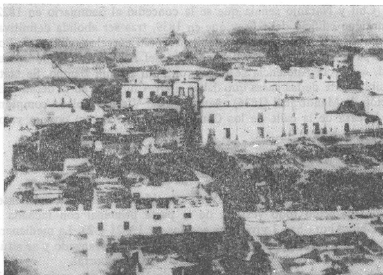
FIG. N.º 4. Fachada principal casi a nivel de la azotea de la casa de la Inquisición con fachada a Dr. Chil. La fecha ha de ser anterior a 1890 ya que el solar que hoy ocupa el museo Canario está desocupado, siendo el inicio de la construcción en esta fecha
