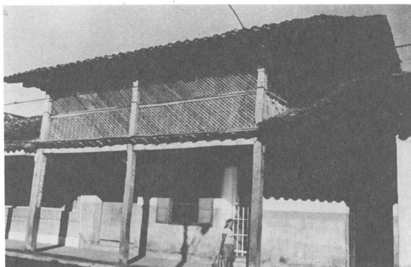
Fig. 7. Santa Cruz de la Sierra (Bolivia). Galería cubierta por celosías.
