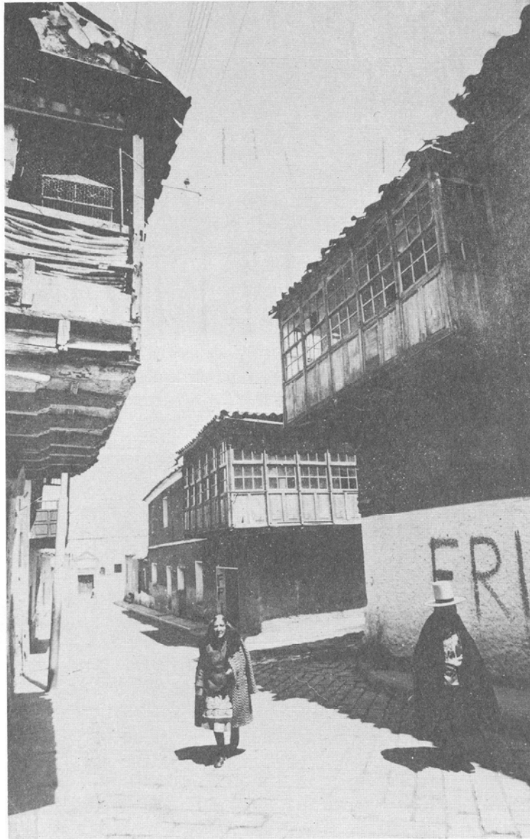
Fig. 20. Potosí. Calle de Santa Teresa, balcones tipo E, de principios del siglo XX.
