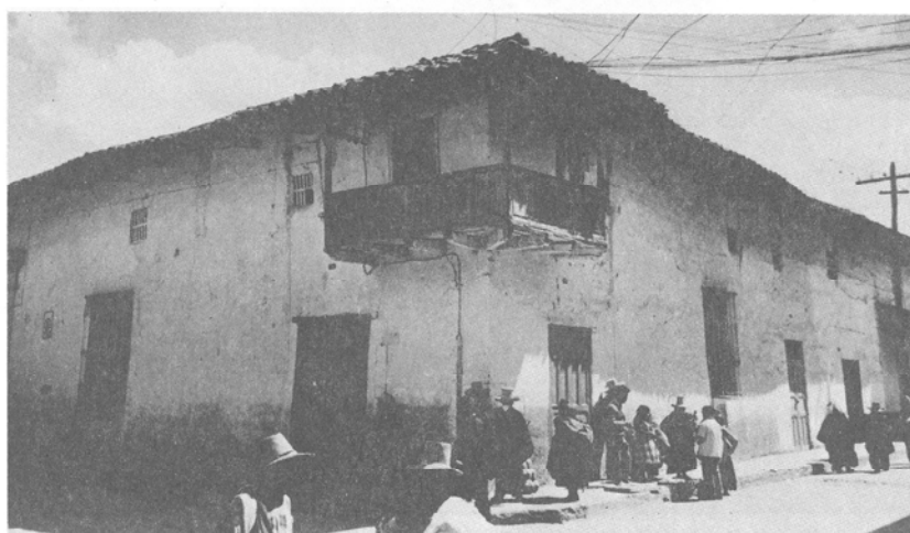
Fig. 8. Balcón de antepecho cerrado (tipo A) en Cajamarca, Perú.
