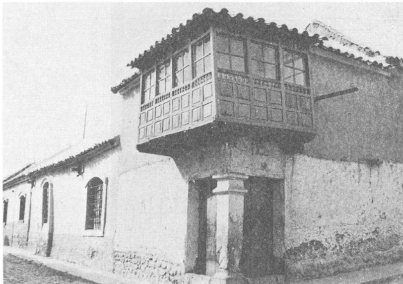
Fig. 11. Potosí. Balcón con balaustres en la parte alta del antepecho.
