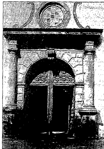
FIG. 12.—Aletas curvas serlianas a ambos lados del óculo. En la Iglesia de San Marcos de Icod de los Vinos. Toda la organización de esta portada es serliana.
