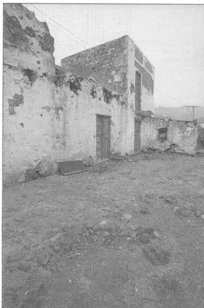
Casa Fuerte, Agaete. Detalle interior del «Patio de Armas».
