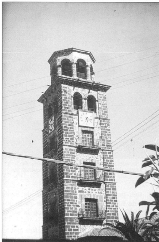
LÁM. 1.—Muchos edificios poseen un alto valor emblemático y sin embargo no se ven libres del impacto visual de los cables de todo tipo que los atenazan. Torre de la Iglesia de La Concepción, La Laguna (Tenerife).
