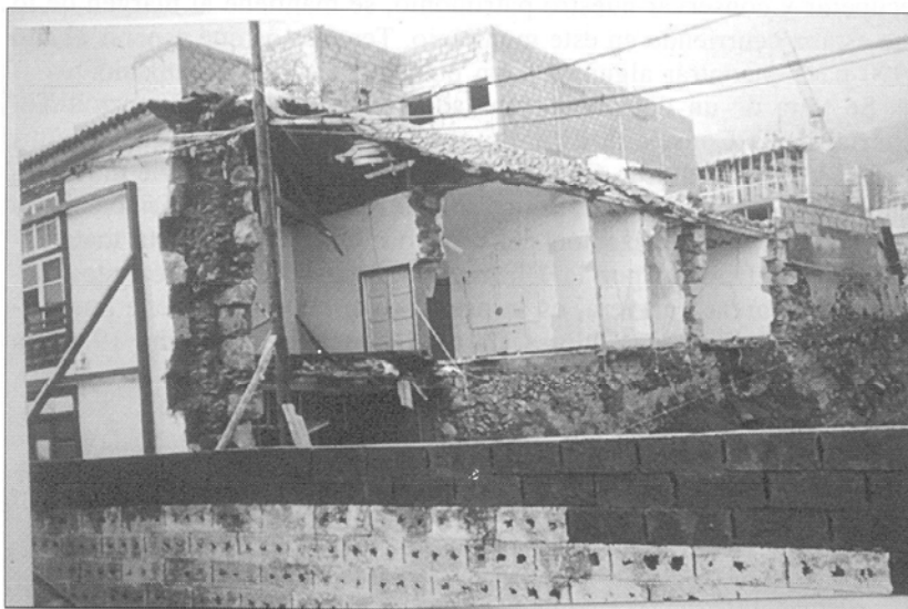
LÁM. 2.—Solar dejado por la desaparecida casa de Don Juan Bueno situada en la calle de Santo Domingo junto a la casa Quintero, Güímar.
