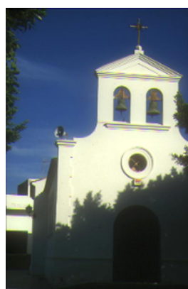
Figura 4. Fachada de la iglesia de San Roque
