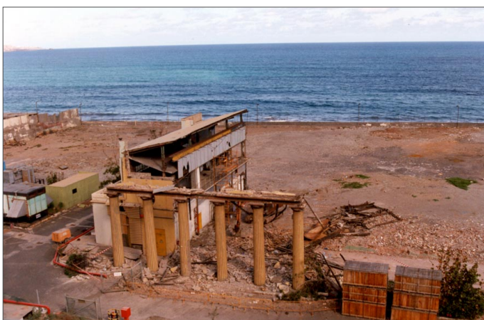
Figura 6. La CICER durante las obras de demolición.
