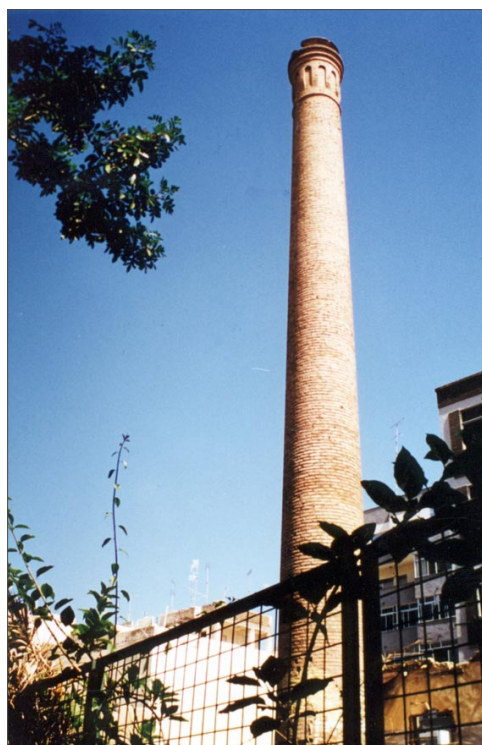
Figura 1. Chimenea de la antigua “Industria Mecánica”.
