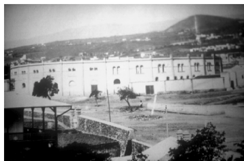
Figura 2. Exterior de la plaza
