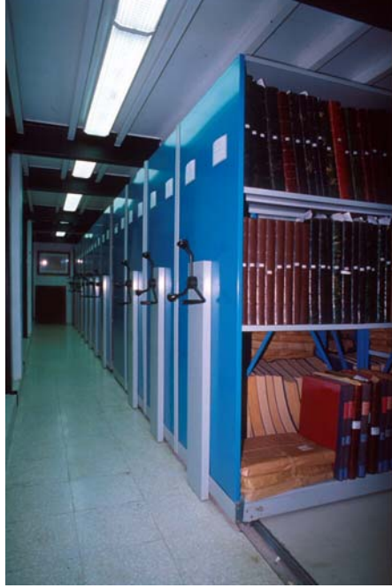
Foto 12. Nuevas instalaciones de compactos realizadas en 1995 en los almacenes de biblioteca, archivo y hemeroteca.
