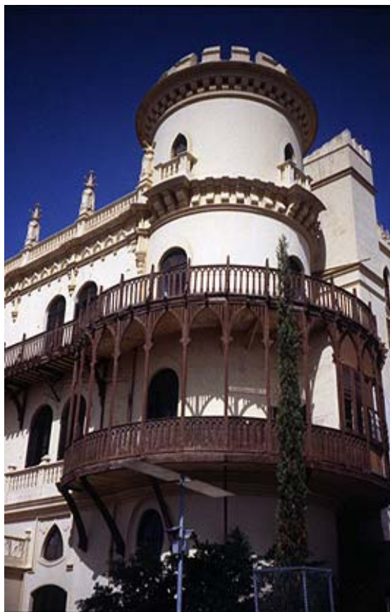
Fig. 5 Donjón francés. Estado actual.
