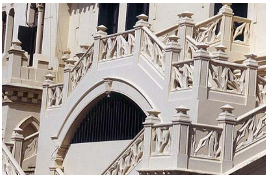
Fig. 4 Escalera principal. Estado actual.
