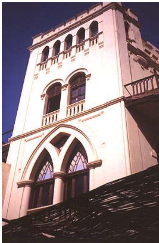
Fig. 6 Torre sienesa. Estado actual.
