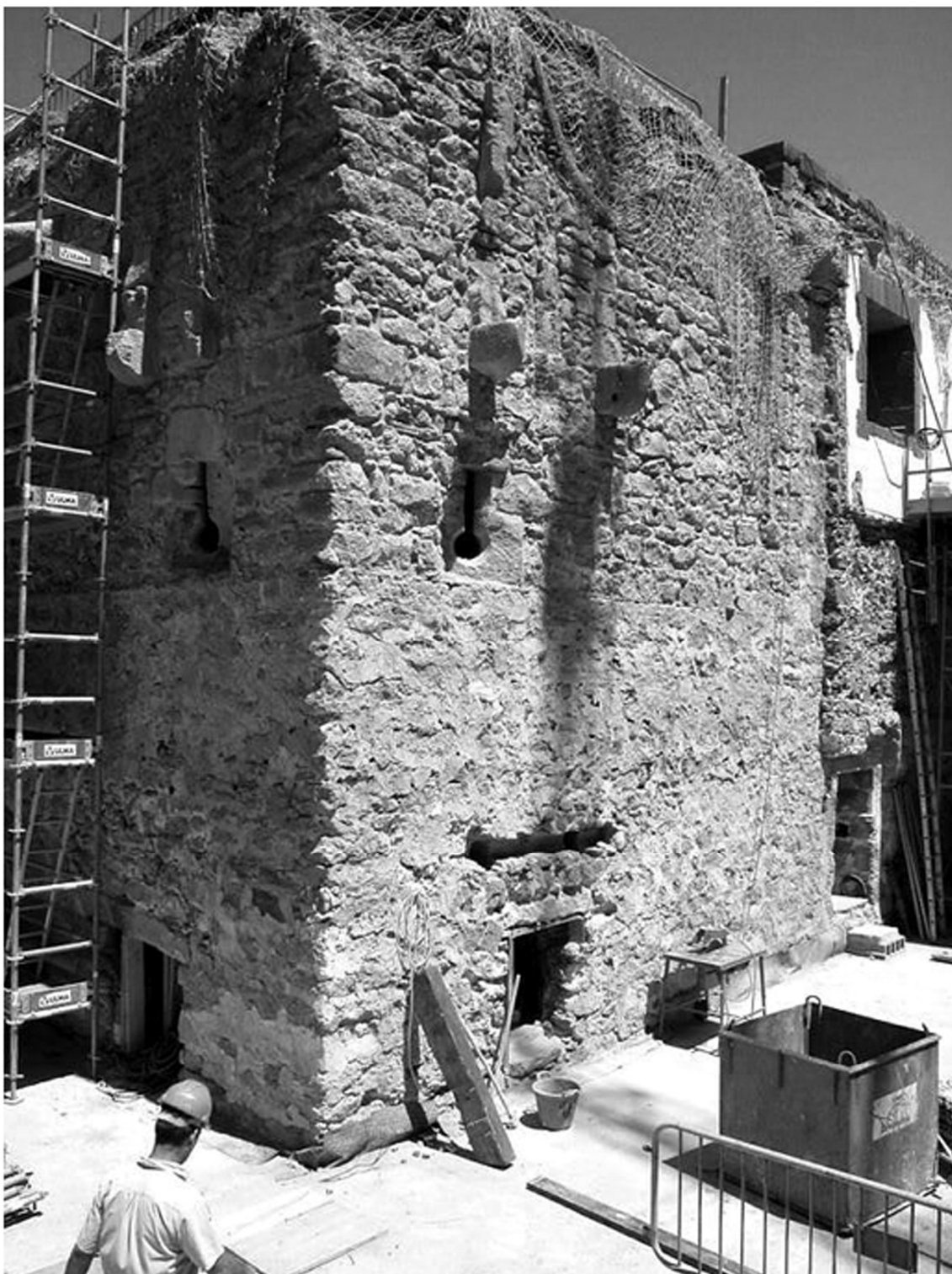
Torre de Alonso de Fajardo durante las obras de rehabilitación.
