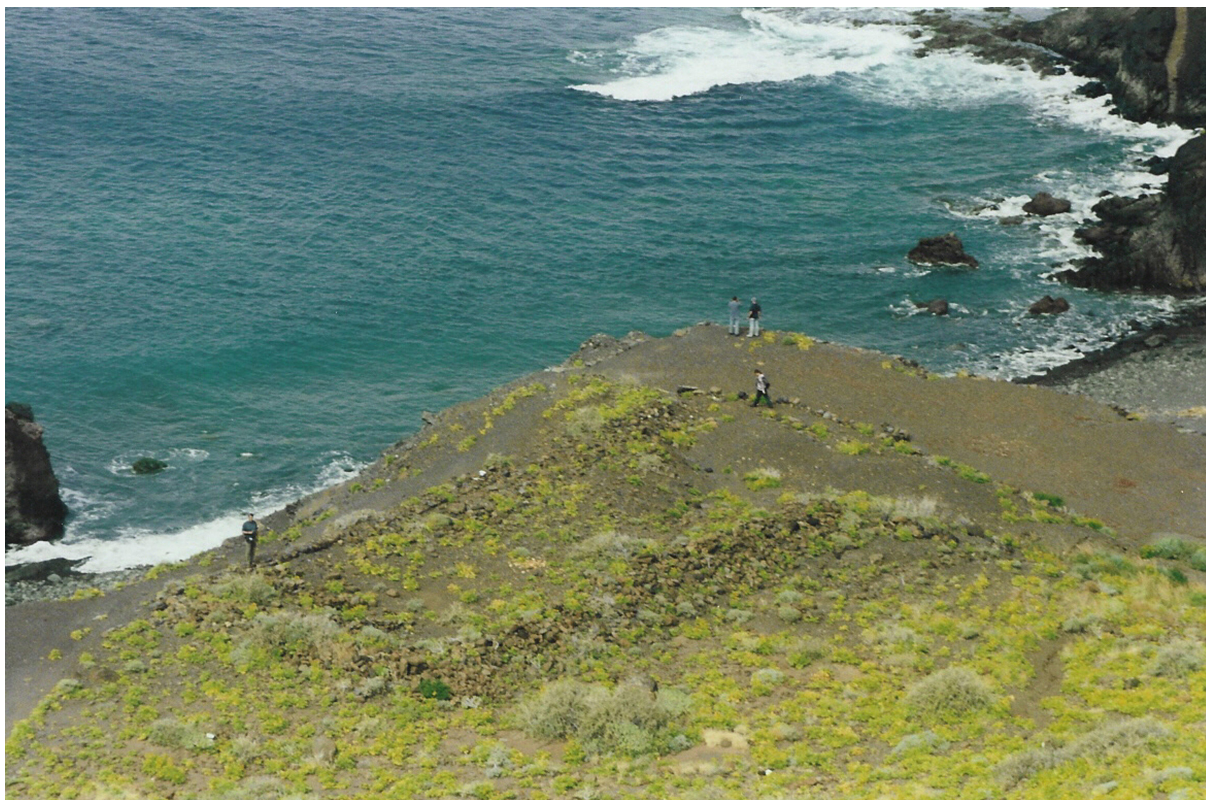
Foto 2. Casilla Pulgar: vista de conjunto.
