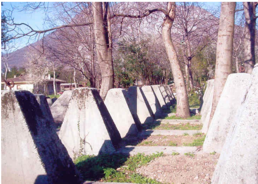
Figura 9: obstrucción anticarro de la Guerra Fría en la frontera entre Friuli y Eslovenia.
