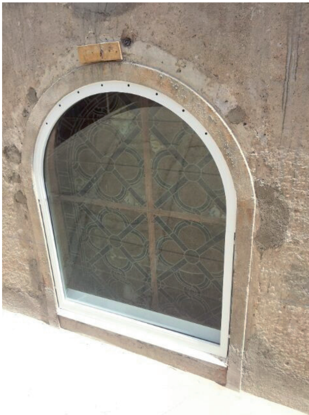
Foto 2: Imagen del autor. Exterior de una vidriera de la nave central con marco de protección de aluminio y vidrio de seguridad. Foto Agosto de 2013.
