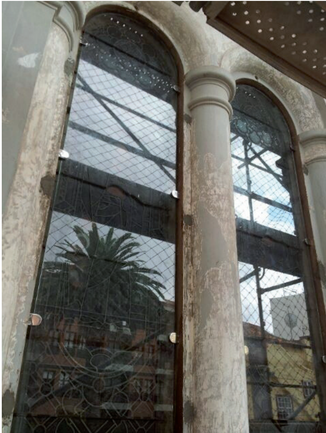
Foto 3: Imagen del autor. Exterior de una vidriera de las capillas laterales desde el exterior donde se aprecia el cristal de seguridad templado sostenido por pinzas de acero inoxidable.
