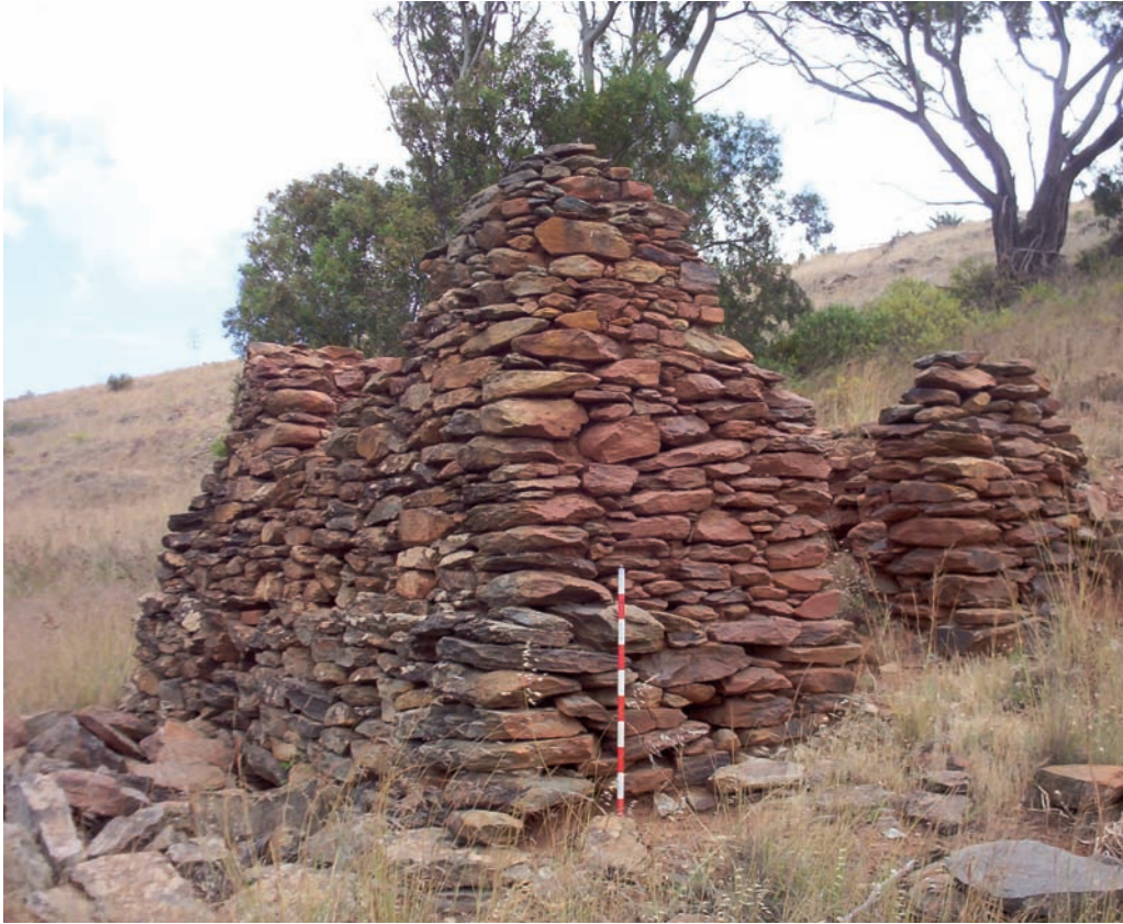
Fotografía 3. Horno de ladrillos, laderas de El Barreto, Lomo de Riquiáñez, Arucas, probablemente del siglo XIX. Foto: A. Jiménez.
