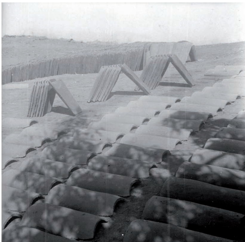
Fotografía 8. Tejas colocadas sobre el “mantillo”. Gran Canaria, años 50. Foto: FEDAC.
