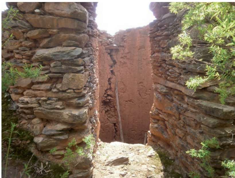
Fotografía 2. Detalle del Horno de Riquiáñez, puerta de acceso a la cámara superior. Foto: A. Jiménez.
