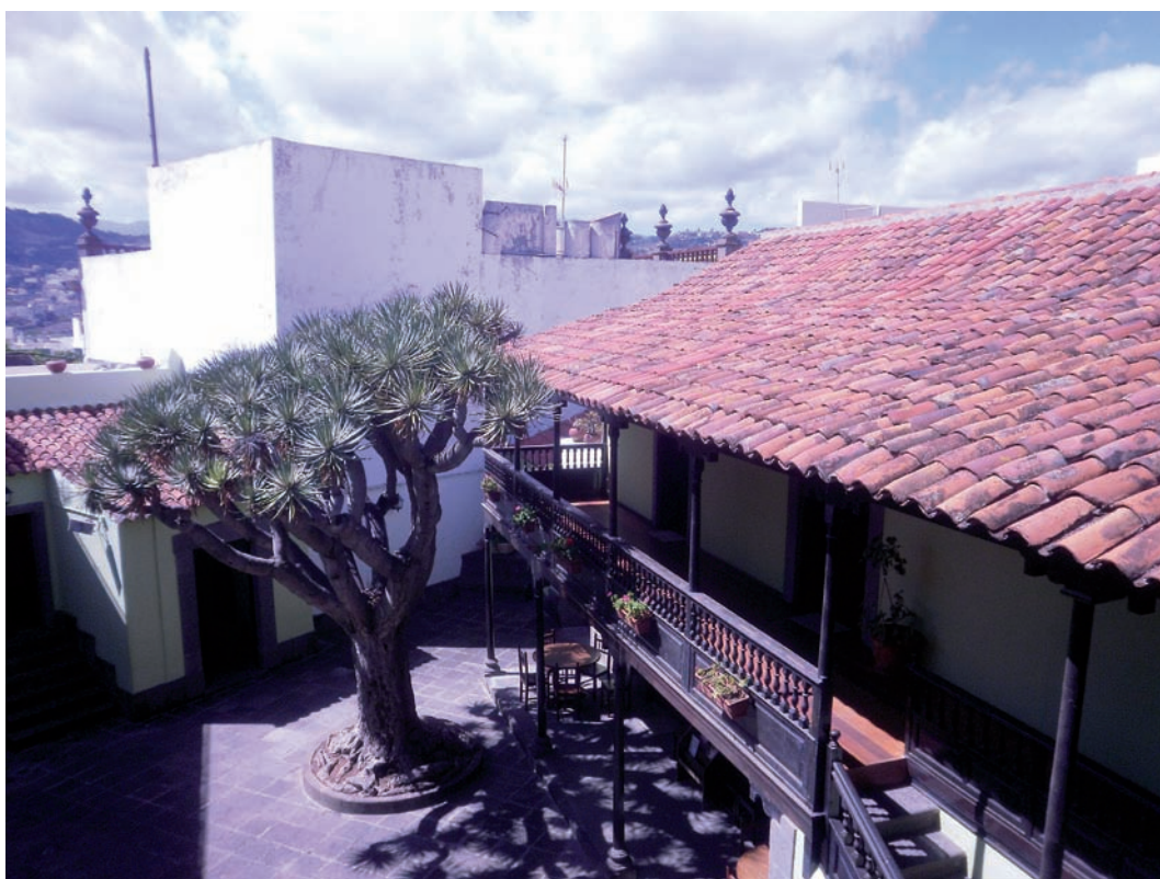
Fotografía 10. Cubierta de tejas. Casa de la Cultura. Arucas. Foto: A. Jiménez.
