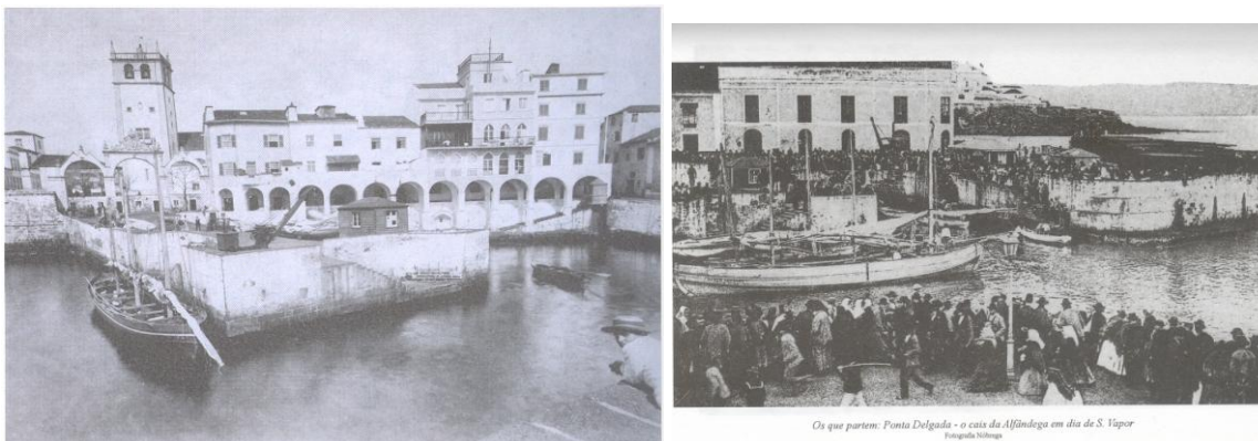
Figs. 3 e 4 – O velho cais de Ponta Delgada, que hoje já não existe, visto do mar, com as Portas da Cidade, ao fundo, à esquerda. À direita, o movimento de cais, em “dia de S. Vapor”. Os elevados fluxos migratórios que deixavam a ilha, saíam, maioritariamente, pelo cais da cidade.
