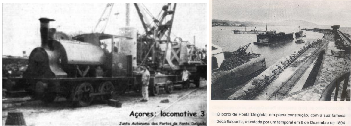
Figs. 5 e 6 – A locomotiva utilizada na construção do molhe. À direita, o processo de construção do molhe, com a doca flutuante, à esquerda, que acabou por se afundar em Dezembro de 1894.
