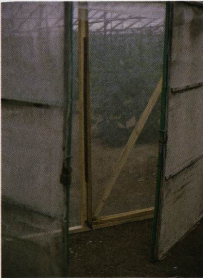
Doble puerta en invernadero
