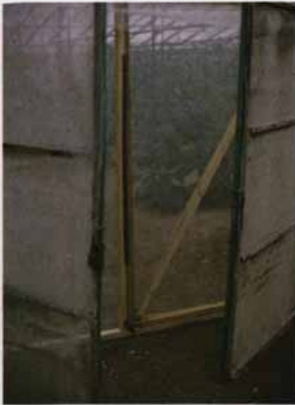
Doble puerta en invernadero
