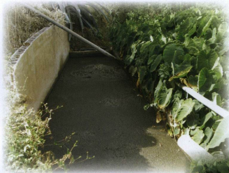
Depósito de retención.
