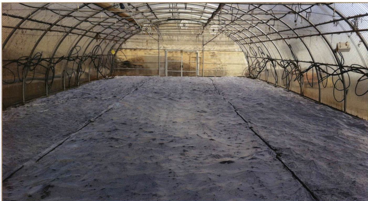
Colocación de plástico de 140 galgas.
