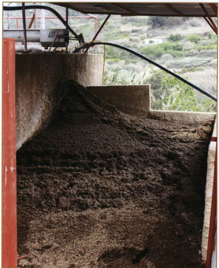
Estercolero de recogida de sólidos.
