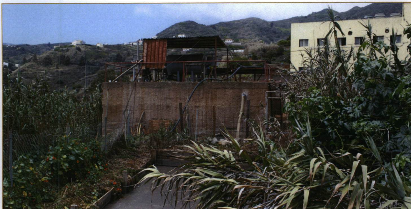
Panorámica de la laguna, el biodigestor y el separador de sólidos.
