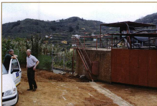
El ganadero D. Hilario Cabrera dialogando con el técnico del Cabildo de Gran Canaria. Y a la derecha de la imagen, el biodigestor y estercolero adosado.
