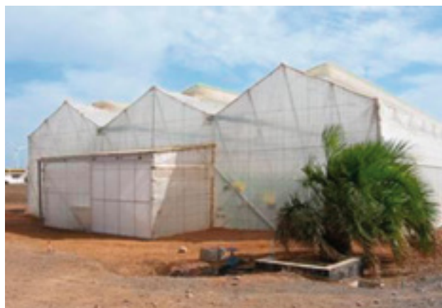
Fotos 1 y 2. Estructura tradicional con cubierta de malla (izquierda) e invernadero multicapilla simétrico, con cubierta de PE y ventanas laterales y cenitales (derecha).
