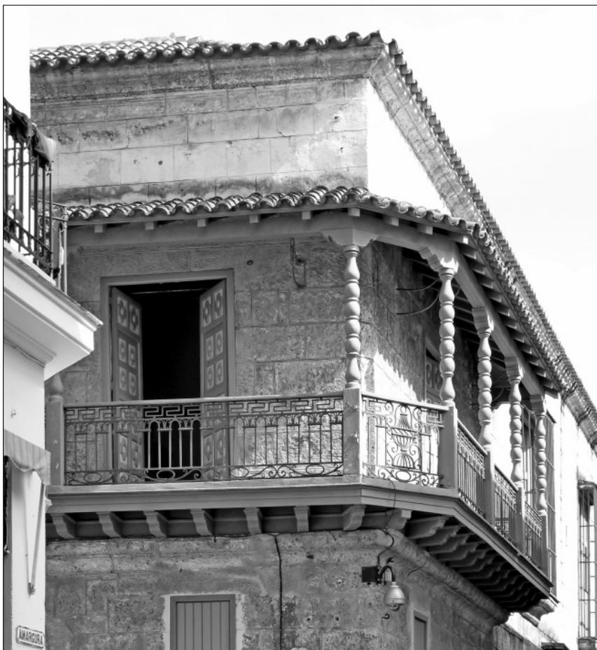
FIGURA 3: Balcón habanero que ha perdido los balaustres de madera y han sido sustituidos por elementos de forja pero que ha mantenido el resto de elementos de madera. Calle Mercaderes esquina con Amargura, La Habana.
