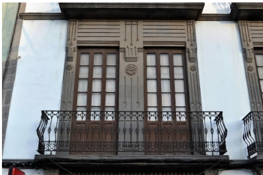
Figura 11. Trilineado acabado en círculos y estrellas. Edificio de la calle Calvo Sotelo nº 15 Las Palmas de Gran Canaria. Foto: el autor.
