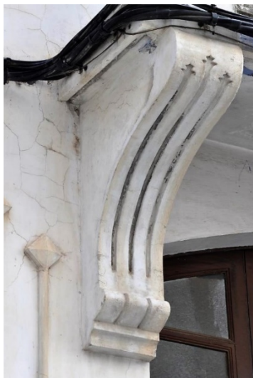
Figura 15. Trilineado en ménsula. Edificio de la calle San Agustín nº 26. Icod de los vinos. Foto autor.
