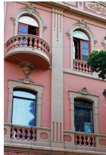
Figura 5. Acanalado interrumpido de pilastra. Edificio de la calle Antonio Domínguez Alfonso nº36. Santa Cruz de Tenerife. Foto: el autor.
