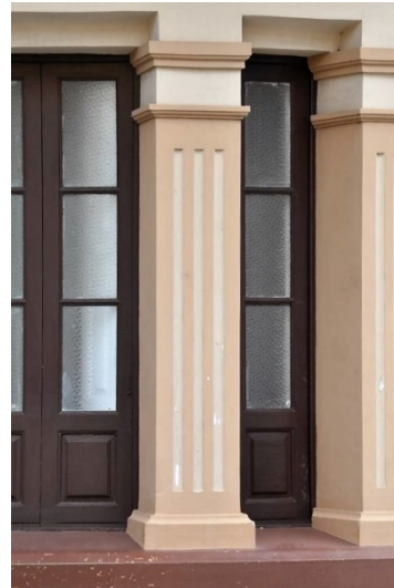
Figura 2. Pilar con 3 acanaladuras. Edificio de la plaza de la Cruz nº 1. Los Silos. Tenerife. Foto: el autor.
