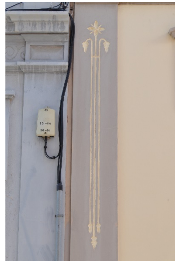
Figura 14. Trilineado esgrafiado. Edificio de la calle Gaspar Fernández nº 5. Santa Cruz de Tenerife. Foto: el autor.
