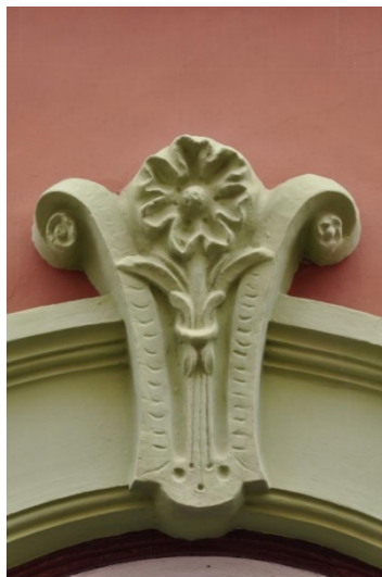
Figura 16. Trilineado en clave de dintel. Edificio de la calle Abajo nº 15. Guía de Isora. Foto el autor.
