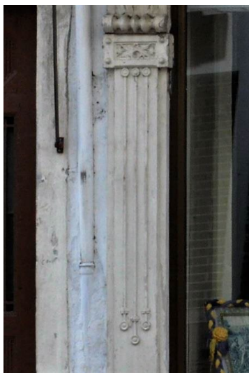
Figura 20. Trilineado de pilastra. Edificio nº 53 Rua Visconde Luz. Coímbra, Portugal. Foto: el autor.
