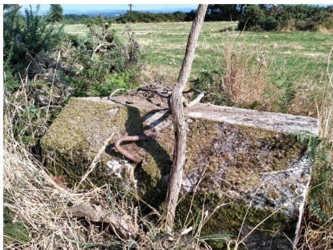
Figura 8. Zapata para anclar cable que arriestraba la torre central en O Arneiro. (Archivo del autor)
