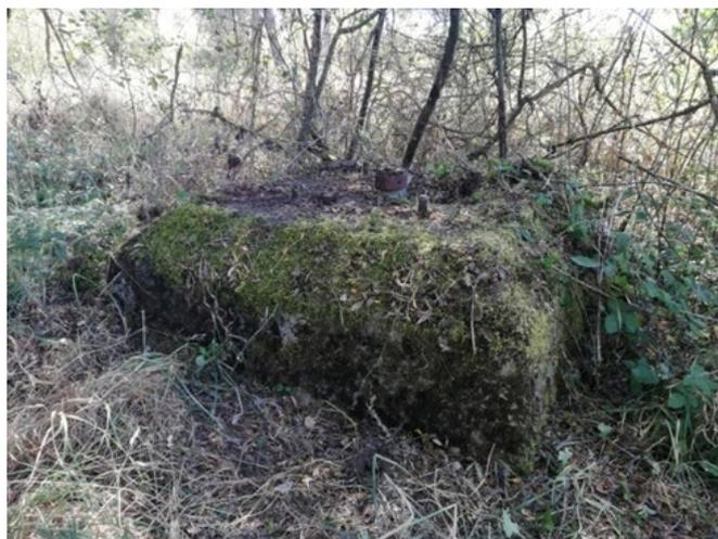
Figura 3. Zapata número 1 red de antenas planta Wullenwever de la ENK. (Archivo del autor)
