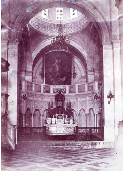
Fig. 2. Interior de la antigua catedral (desaparecido).
