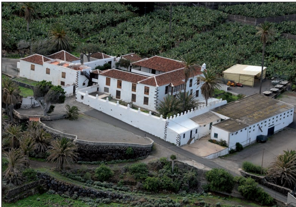
Figura nº 2. Panorámica de conjunto actual.
