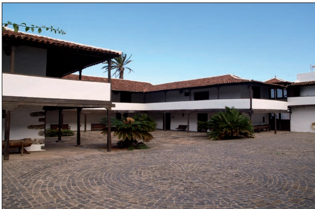
Figura nº 4. Perspectiva actual el patio de la Hacienda.
