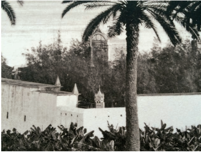
Capilla para guardar el monumento fúnebre de Cristóbal del Castillo (Detalle).
