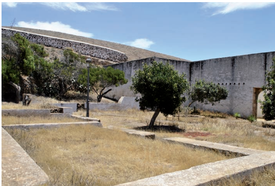
Vestigios arquitectónicos de las habitaciones del convento. Foto del autor.
