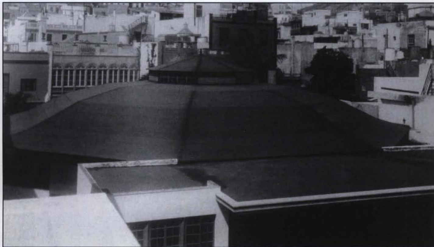
Cubierta de madera levantada tras el incendio de 1908
